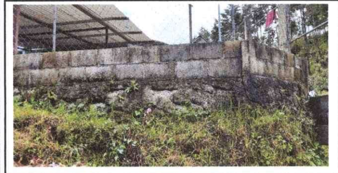
Foto 11: Reforzamiento de columna de muro de contención.
