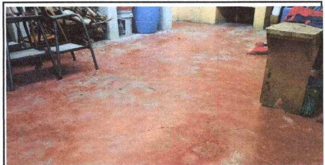
Foto 16: Colocación de piso liso a piso cerámico.
