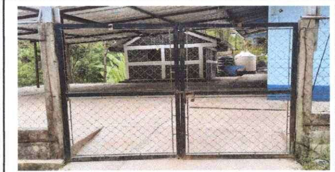
Foto 7: Sustrucción de Porton de Ingreso.
